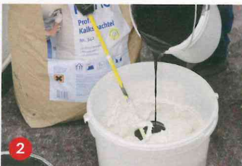
2 Die Graufärbung erreichen Sie durch die Zugabe von schwarzer Kalkfarbe. Achtung: Die Farbe macht den Putz wieder etwas flüssiger.
