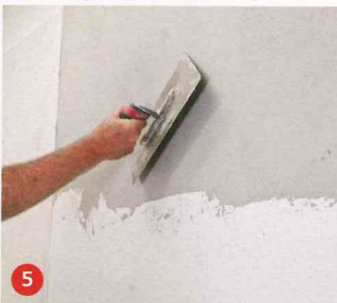
5 Mit etwas steilerer Kelle können Sie die Materialdicke auf Kornstärke abziehen. So fällt später die gleichmäßige Strukturierung leichter.
