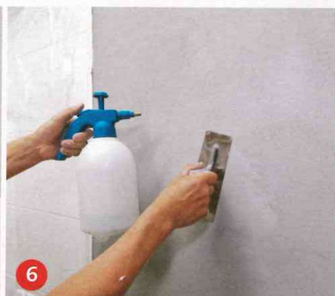
6 Die Venezianische Kelle mit den abgerundeten Ecken verwenden Sie, um die leicht angefeuchtete Lehmoberfläche zu glätten.
