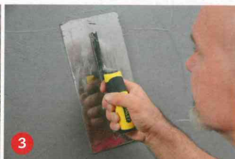
3 Nach dem Auftragen des Putzes lassen Sie die Masse leicht anziehen, bevor Sie per Metall- oder Kunststoffglättern die Fläche verdichten.
