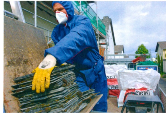
Asbestsanierung wie die Entsorgung von Dachplatten ist eine Aufgabe für Profis. Unsachgemäßes Vorgehen gefährdet alle Beteiligten auf der Baustelle. Rathscheck
