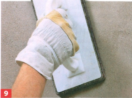
9 Gibt der Putz bei Daumendruck nicht mehr nach, hat er ausreichend angezogen, um mit angefeuchtetem Filzbrett in kreisenden ...
