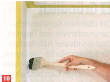
10 ... Bewegungen geglättet zu werden. Nach kompletter Trocknung streicht man den Kalkputz mit Kalkfarbe; erst die Ecken mit Pinsel.
