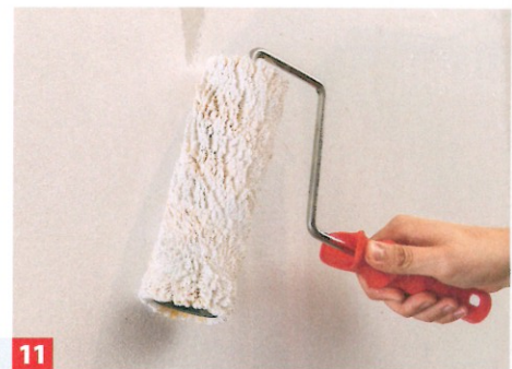
11 Dann streicht man die Flächen mit der Rolle oder mit der Streichbürste im Kreuzgang (abschließend in eine Richtung rollen).
